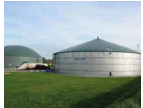
gasdichte Spannfolienabdeckung (ein-oder zweischalig)
